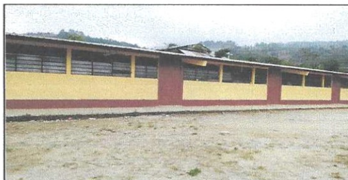
Foto 6: como se puede observar los vidrios se necesita mantenimiento, quebradas ,laminas sin canaletas, paredes deterioradas
